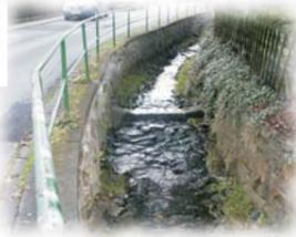
aber, dass der einst freie Bachlauf in ein Korsett aus Sandsteinen und Beton gefasst und auf längeren Strecken mit Betonplatten abgedeckt wurde. Die lustigen Kurven wurden begradigt und damit das schneller fließende Wasser nicht zu viel kaputt machte, wurde die Sohle mit Beton befestigt und Schwellen eingebaut.
