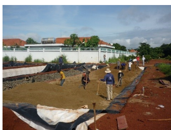
Einbau des Substrats
