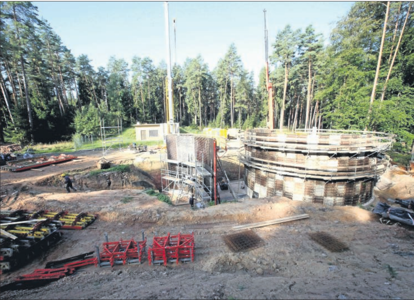
Baustelle im Wald: Rund 2400 Quadratmeter wurde für den Bau des neuen Hochbehälters gerodet. Zum Ausgleich wird eine Fläche im Bereich des Mühlenholzes zwischen Altenstadt und Ippinghausen aufgeforstet.
