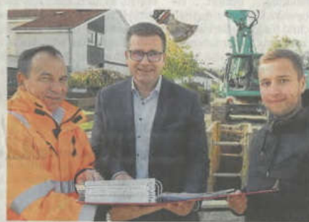
Baustellenbesichtigung in der Liebauer Straße in Mönchehof: Bürgermeister Carsten Strzoda (Mitte) wird von Bauingenieur Florin Stanciu (von links) und Bauleiter Sascha Hofeditz auf den neusten Stand gebracht.
