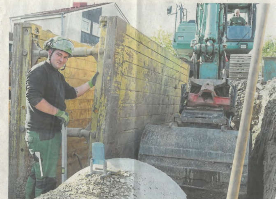
Bevor Julian Prange (links) beim Verlegen des nächsten Kanalabschnitts in der Liebauer Straße in Mönchehof auf Passgenauigkeit achten muss, schafft Baggerfahrer Jörg Hofeditz Platz.
