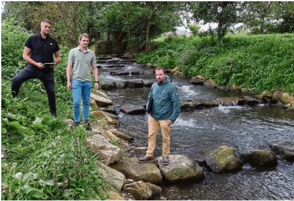
Schrittweise Höhe gewinnen können Tiere nun über acht Becken, die die Firma Emmeluth, Christoph Hartmann (Bauamt) und Gewässerplaner vorstellten.
