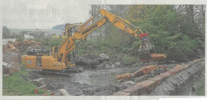
Bis zu drei Bagger sind an der Baustelle der Esse in Hümme im Einsatz. Das marode Wehr wurde abgebrochen und entlang des Mühlgrabens (vorne rechts) eine höhere Mauer errichtet. Im Flussbett wird eine Fischtreppe gebaut, die insgesamt 1,50 Meter Höhenunterschied überwinden wird.
